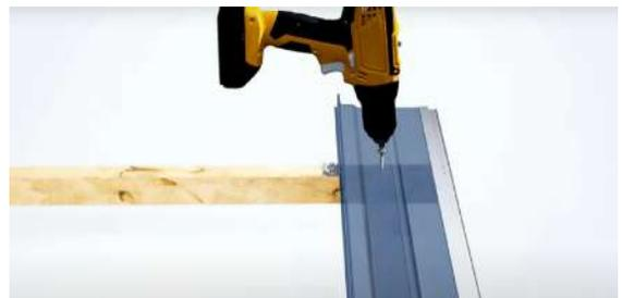
Colocar tornillos en el perfil superior de la estructura para asegurar la lama.
