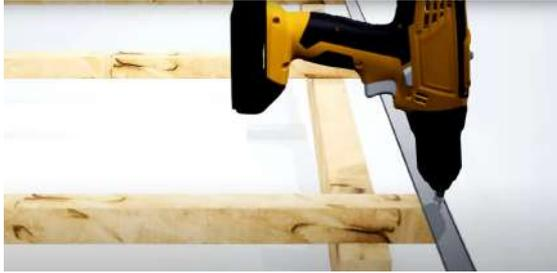
Atornillar el perfil lateral en el extremo de la estructura.
