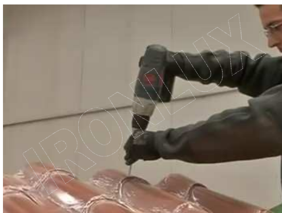
FIJAR EL PANEL DIRECTAMENTE A LA ESTRUCTURA. SIEMPRE POR LA PARTE ALTA DE LA ONDA.
