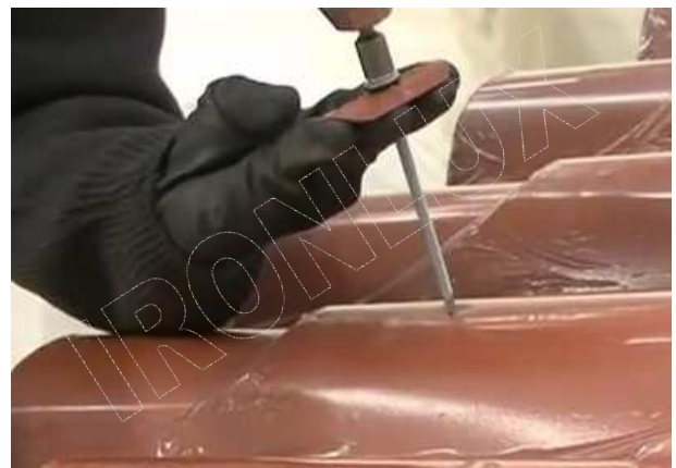
FIJAR EL PANEL DIRECTAMENTE A LA ESTRUCTURA. SIEMPRE POR LA PARTE ALTA DE LA ONDA.
