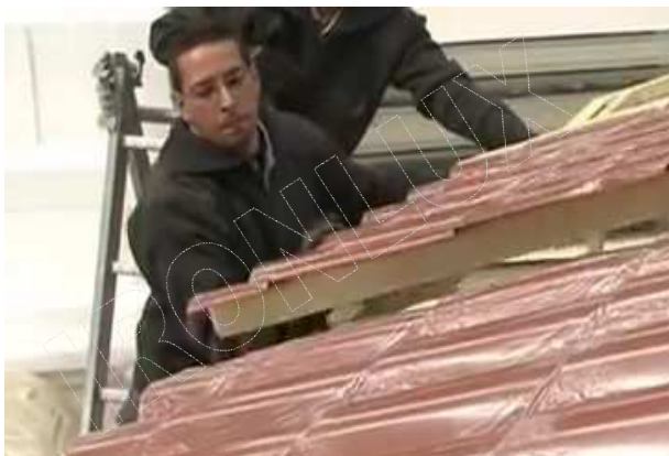
SITUAR EL SEGUNDO PANEL HASTA ASEGURARSE QUE ENCAJEN CORRECTAMENTE LAS TEJAS.
