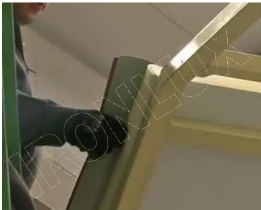
ALINEAR MUY BIEN EL PRIMER PANEL CON LA ESTRUCTURA
