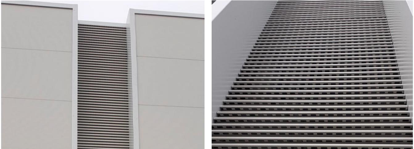
Chapa perfilada Formentera para fachadas, con o sin perforar. La gran particularidad de esta chapa, cuando se fabrica con perforado, es que permite pasar el aire actuando como sistema de ventilación. Ideal para instalar en fachadas arquitectónicas donde se busque un alto grado de intimidad ya que permite ver desde dentro del edificio pero no desde afuera.
