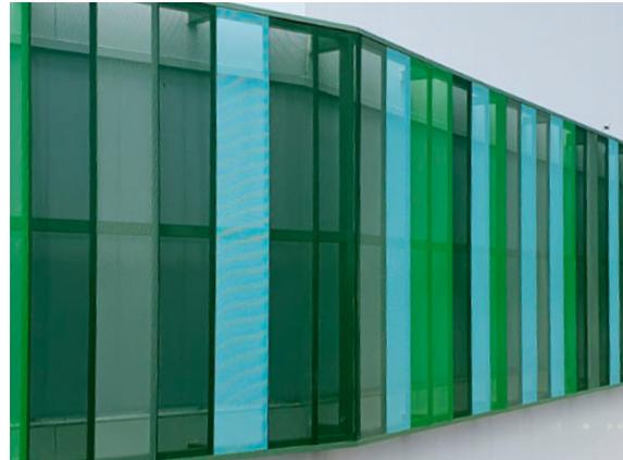
Bandejas arquitectónicas para fachada, chapa que se compone de acero de calidad DX51D según UNE-EN 10142.
